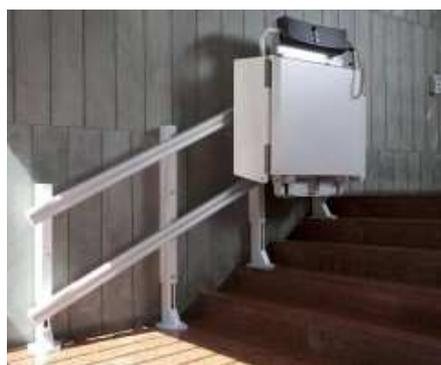
Esempio di servoscale per l'abbattimento delle barriere architettoniche
