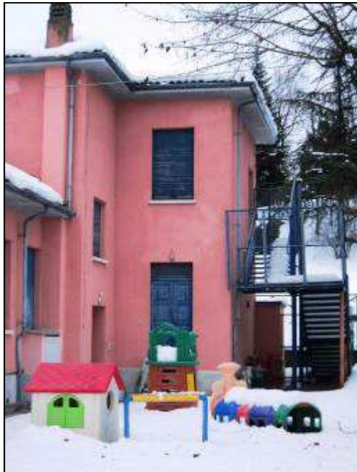
Foto 7: Dettaglio prospetto Sud
