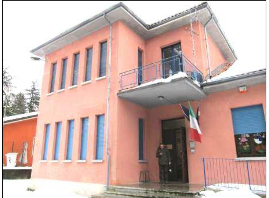
Foto 2: Prospetto Nord – Ingresso scuola
