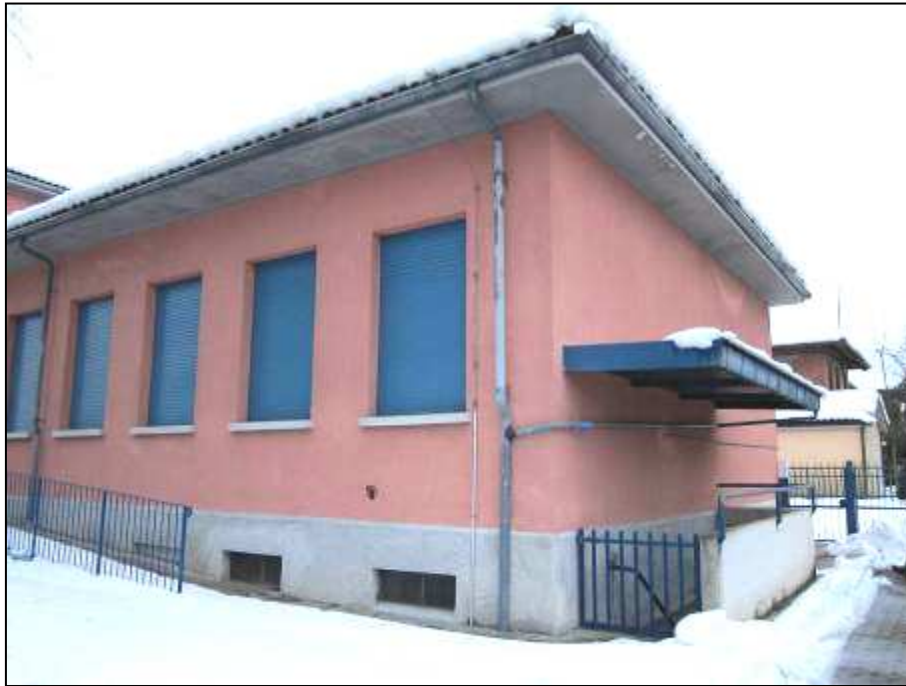
Foto 4: Vista lato Nord – Ovest
