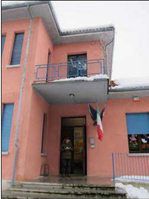
Foto 1: Prospetto Nord – Ingresso scuola
