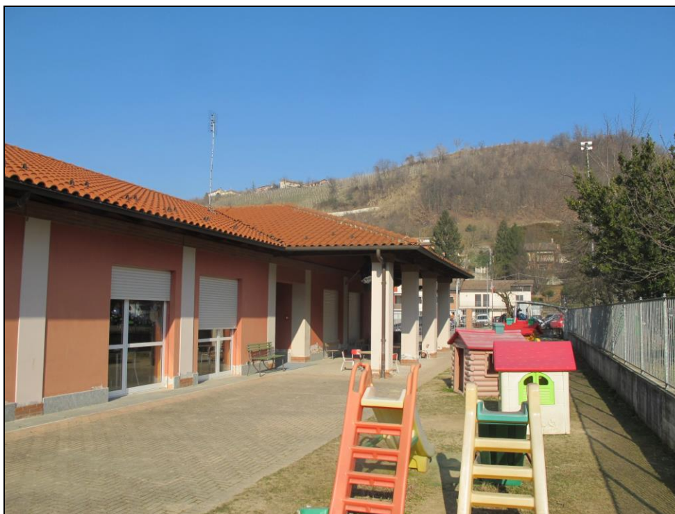
Foto 2 - Vista della Scuola
