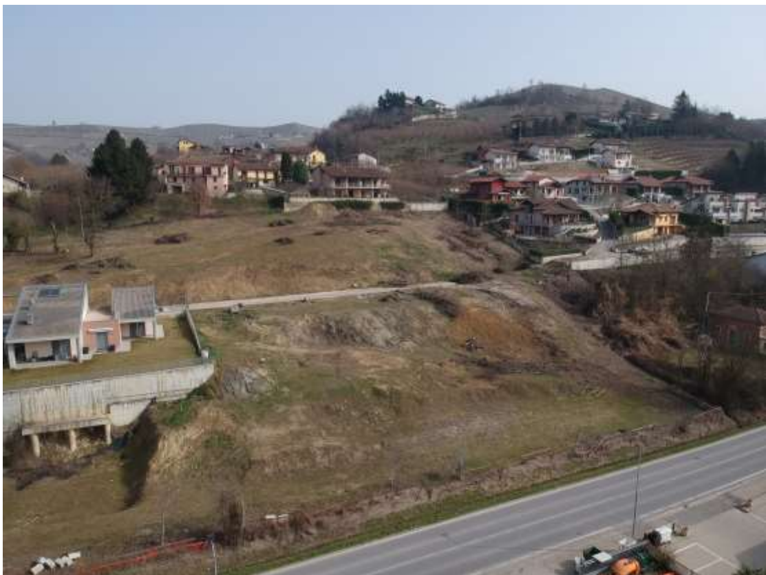
FOTOGRAFIA 6: VISTA della ZONA a VALLE della STRADA DI P.E.C.
