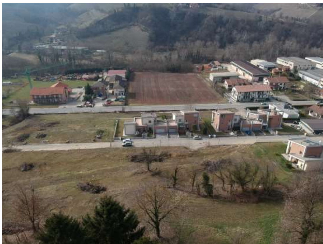
FOTOGRAFIA 2: VISTA GLOBALE del terreno di P.E.C. verso ovest
